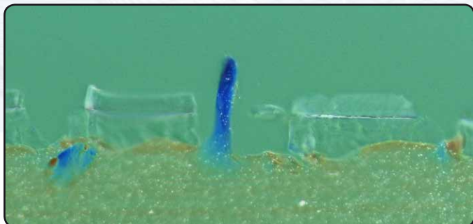
Défaut sur un enduit lustré
